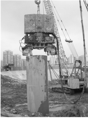
图 5 振动锤下沉护筒
