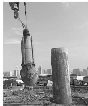
图4 冲抓锥起吊入孔抓取填石
