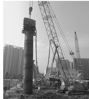
图3 振动锤沉入长护筒
