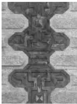
图9 出砖入石墙面
