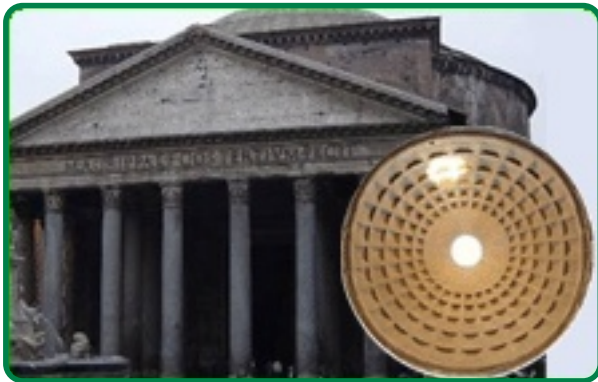
Figura 1. Panteón de Roma. Construido inicialmente por Agripa en 27 AC y reconstruido totalmente por Adriano en 126 DC. La bóveda está hecha de hormigón.
